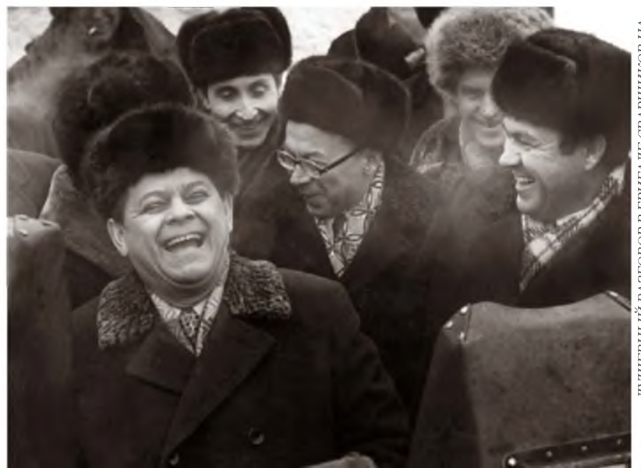
ДУШЕВНЫЙ РАЗГОВОР В БРИГАДЕ СВАРЩИКОВ НА ТРАССЕ ГАЗОПРОВОДА. ТЮМЕНСКАЯ ОБЛАСТЬ, 1978 Г.
