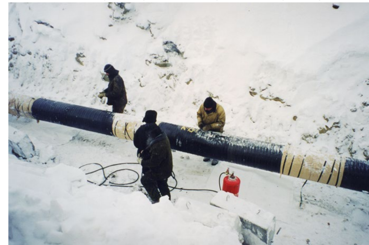
Монтаж газопровода шлейфа в заводской теплогидроизоляции на Заполярном месторождении
