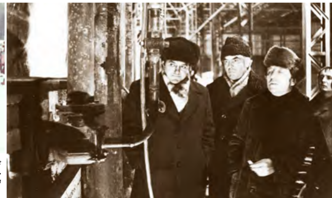
На строительстве кирпичного завода, г. Надым
