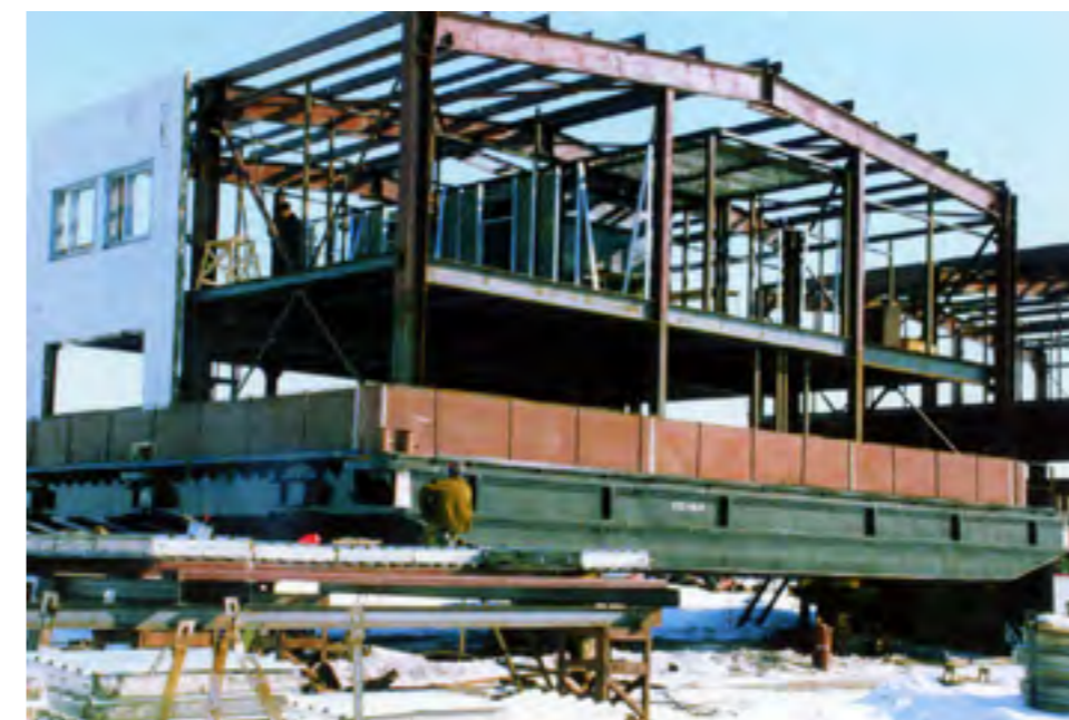
Сборка суперблока
