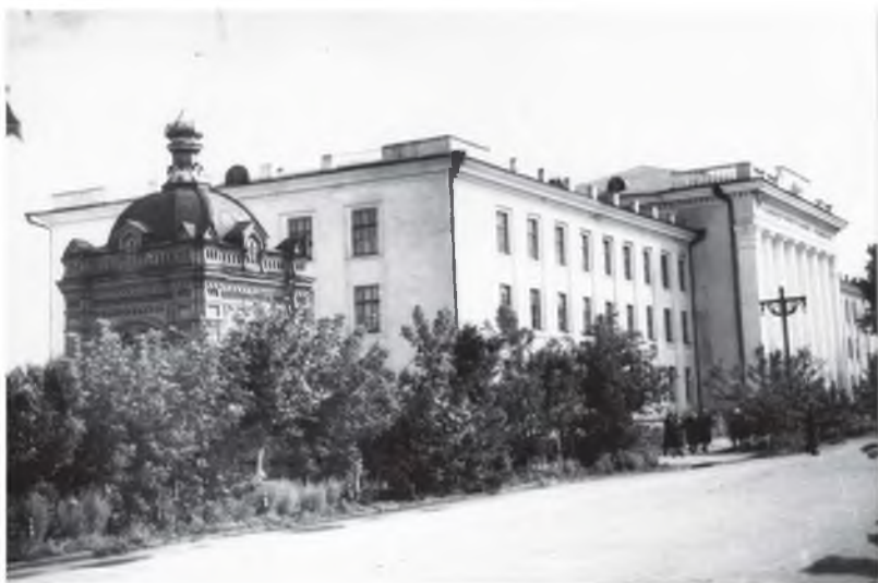
Часовня. Вид с западной стороны. Фото 1950-х годов
