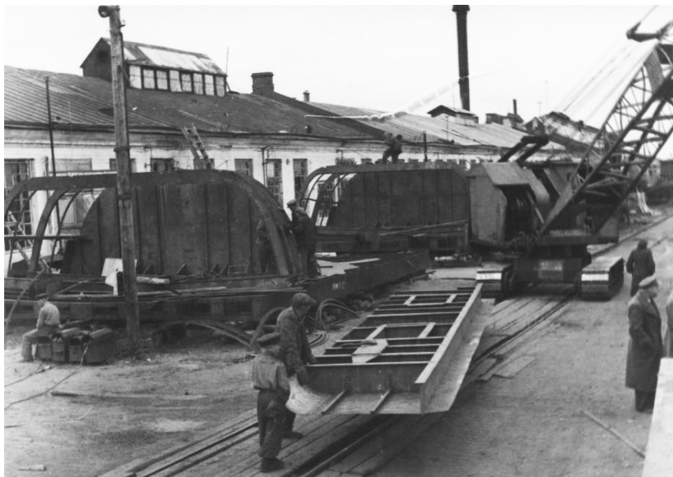
Судостроительный завод. Рабочий момент стройки
