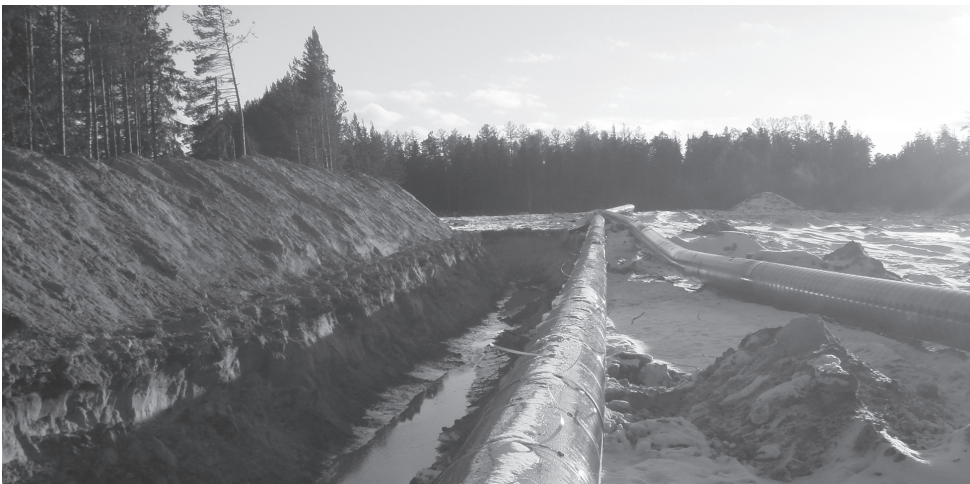
Укладка трубы в траншею
